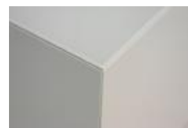
Łączenie na ucios wszystkich ścian
